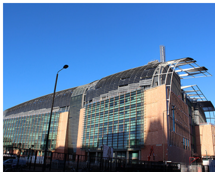
建設中の Francis Crick Institute
