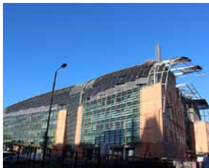
建設中の Francis Crick Institute
