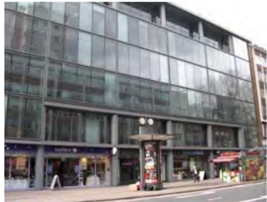
NAASHロンドン事務所外観
