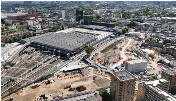
ユーストン駅周辺の再開発中の風景。 https://www.hs2.org.uk/building-hs2/stations/euston/
