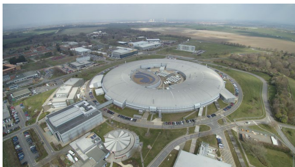
○Diamond Light Source 全景
